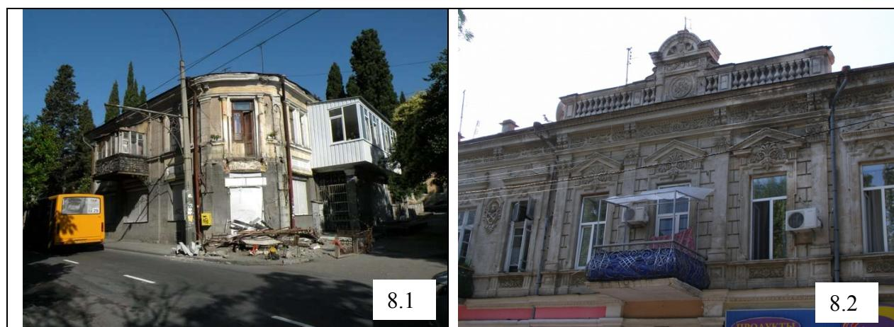
**Рис. 8. Разрушение фасадов старинных зданий**
